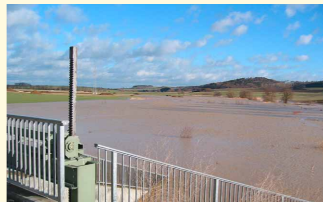
Bild oben: Hochwasser
