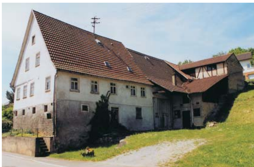
Ein leerstehendes ländlich geprägtes Gebäude
